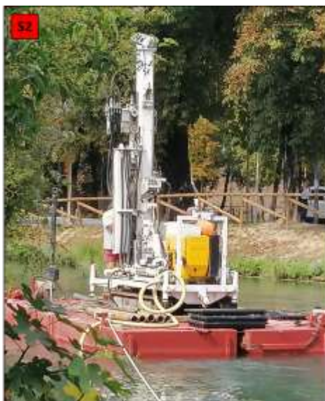
Foto esecuzione sondaggi S1, S2 e S3
